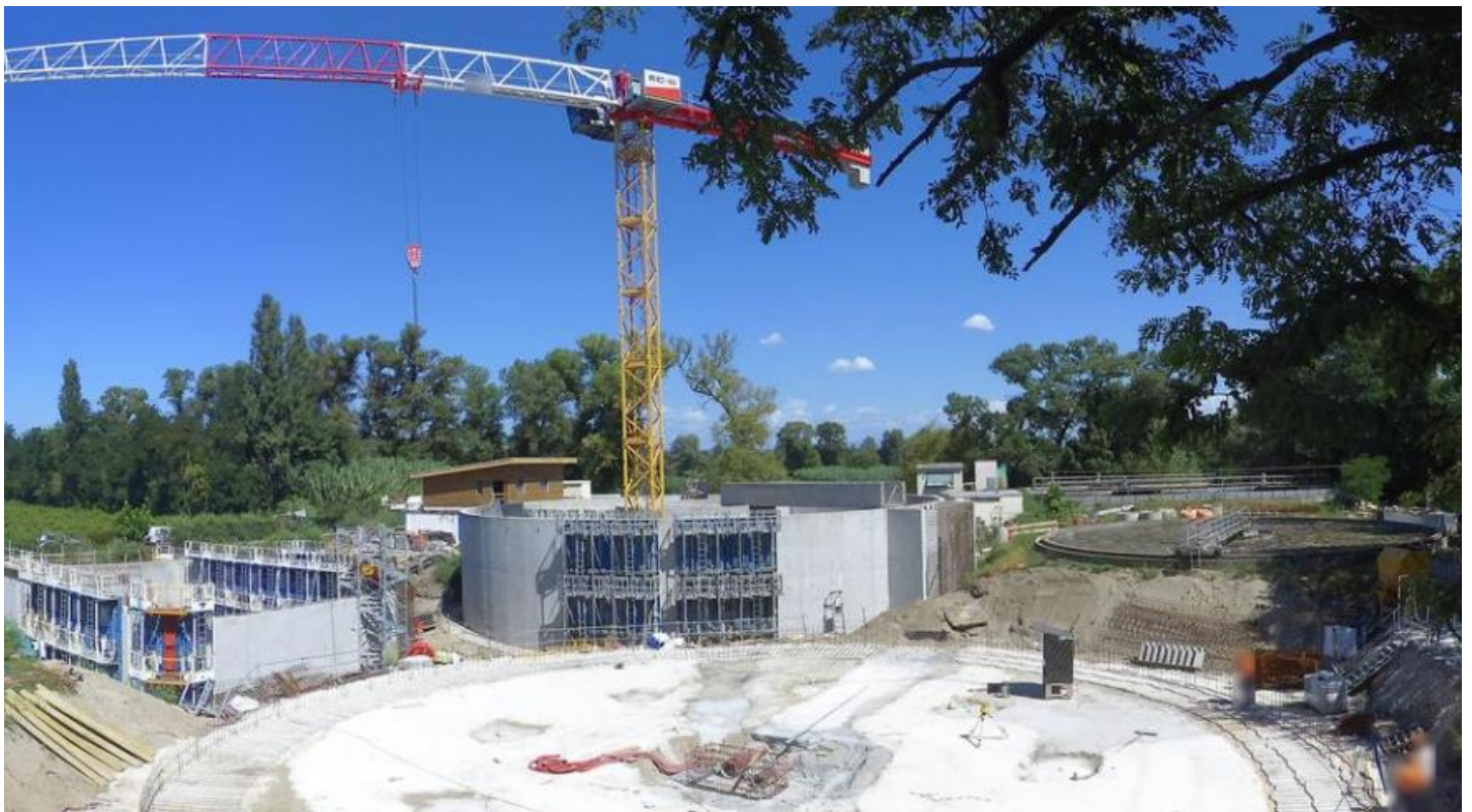
Station d'épuration de Pont Saint Esprit en cours de réhabilitation – 2024
