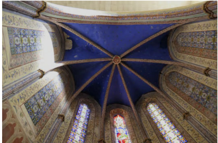
Détail de la voûte d'ogive à huit quartiers rayonnants du chœur - Source : échelle 1, Gabrielle Welisch, architecte DPLG
