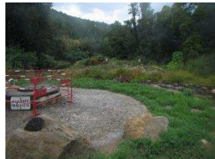
Figure 13 : Scarification Montjoie septembre 2023
