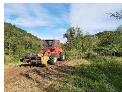
Figure 11 : Entretien de la digue de Saint-Ambroix
