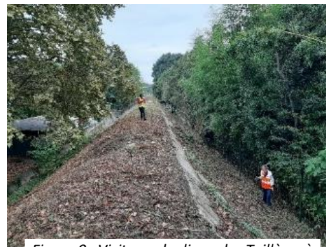
Figure 9 : Visite sur la digue des Tuillères à Pont Saint Esprit
