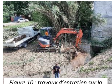
Figure 10 : travaux d'entretien sur la digue de des Tuilières à Pont Saint Esprit
